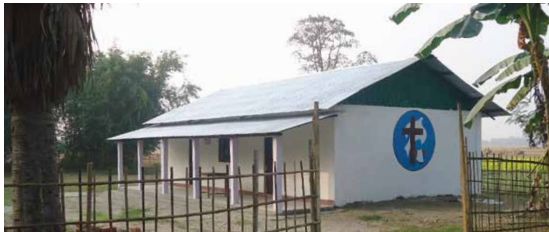
El nuevo edificio de hormigón en Babiya, Nepal, construido con la ayuda del Fondo de Ayuda de la Iglesia Mundial del CMM.
